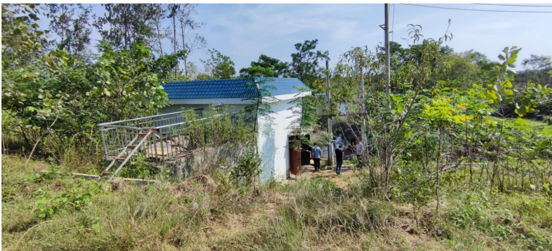
图 3.2-34 张愚站出水侧现状
