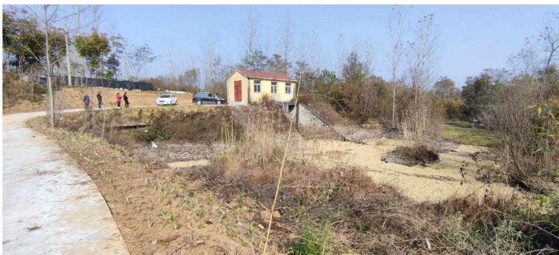
图 3.2-20 段口站进水侧现状
