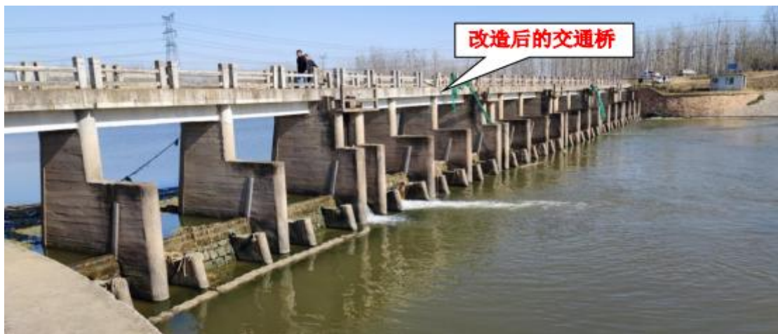
图 3.2-8 袁滩闸下游立面现状
