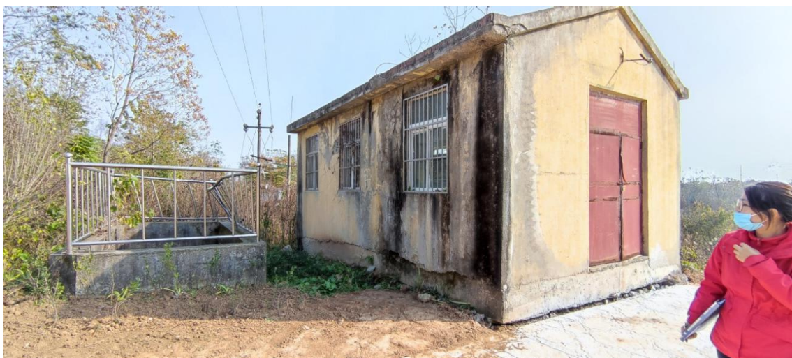
图 3.2-21 段口站出水池侧现状
