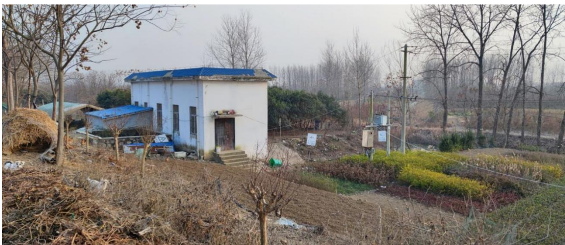
图 3.2-17 虞北站进水立面现状
