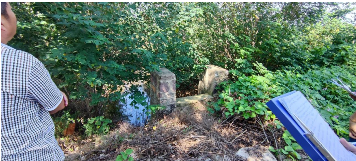
图 3.2-42 花晏圩东闸现状无节制，容易形成倒灌
