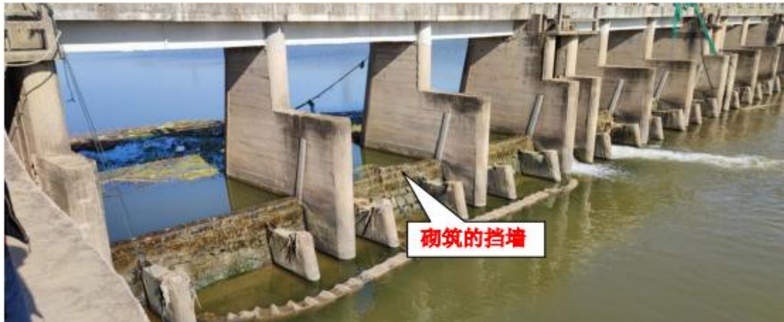
图 3.2-7 袁滩闸闸孔现状
