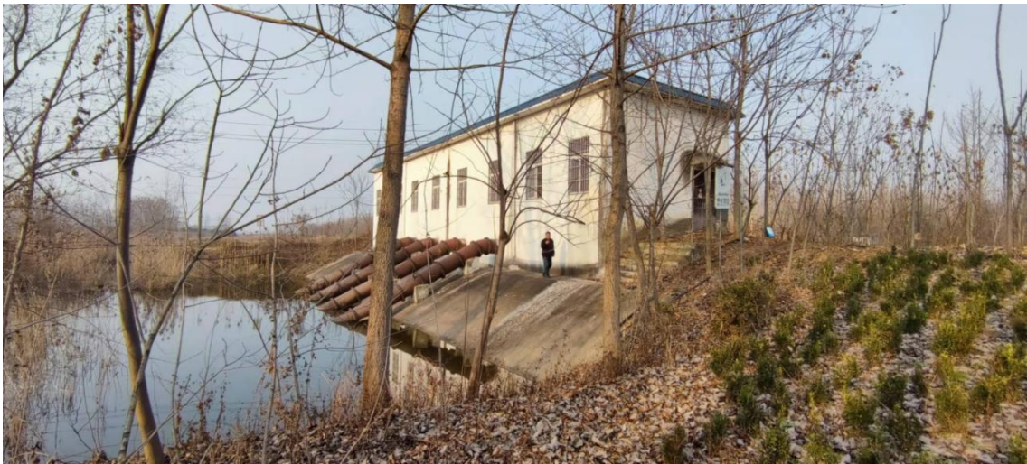
图 3.2-9 吴滩排涝站进水侧立面
