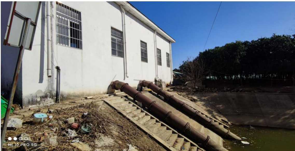
图 3.2-16 虞北站进水立面现状
