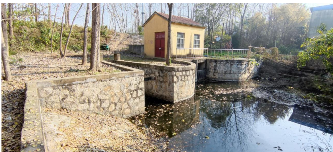
图 3.2-28 王庄站进水侧现状
