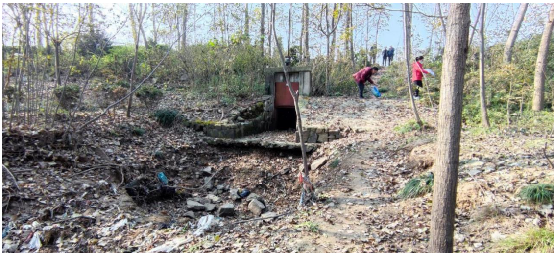
图 3.2-27 徐口站穿堤涵洞出水侧现状
