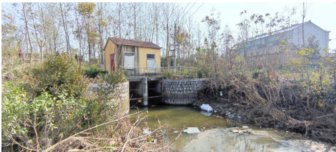
图 3.2-23 徐口站进水侧现状
