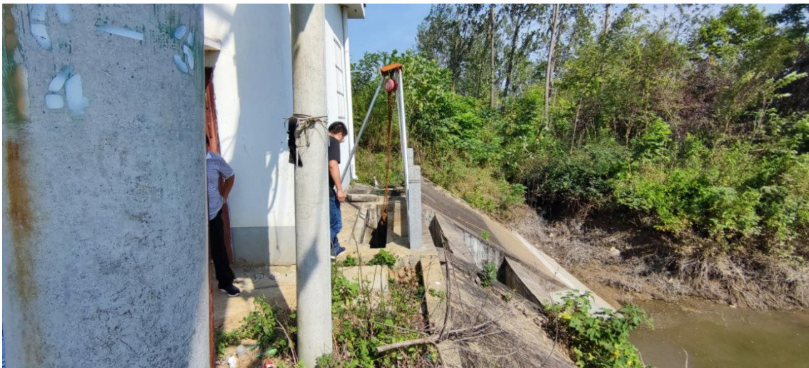
图 3.2-33 张愚站进水侧现状
