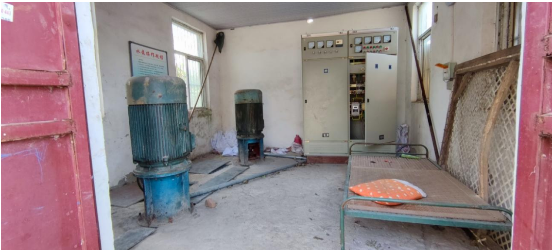
图 3.2-25 徐口站泵室内现状
