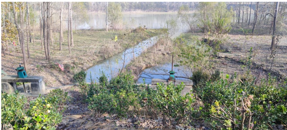
图 3.2-29 王庄站出水侧现状
