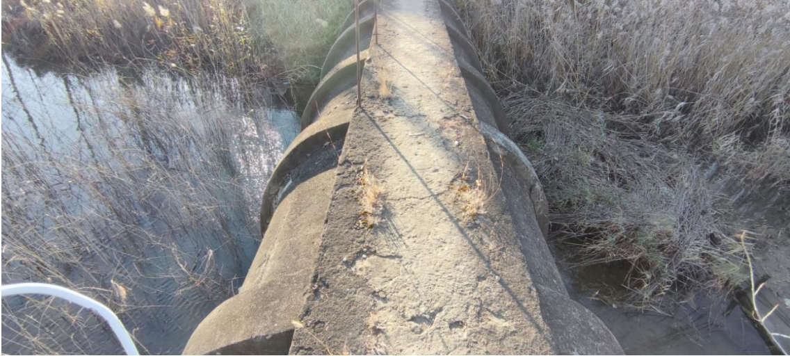
图 3.2-11 吴滩排涝站现状出水涵管
