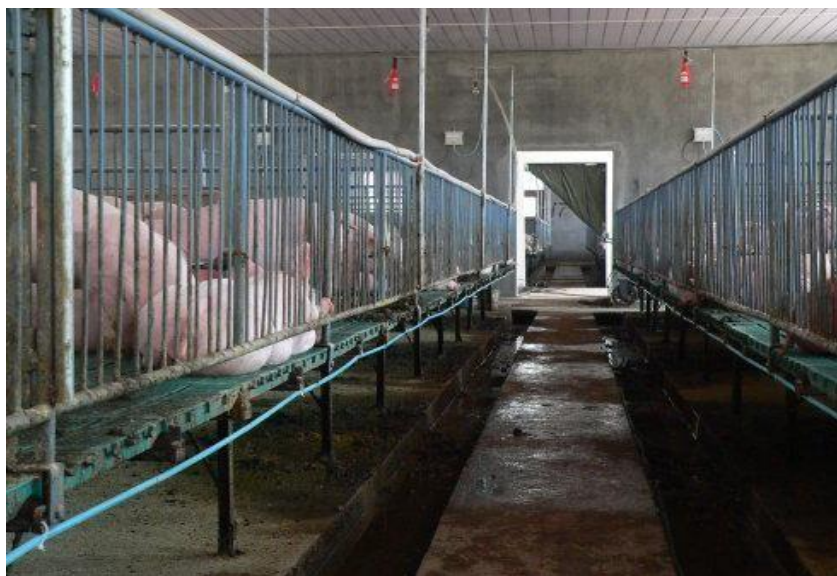
图 6.2-2 等离子体输送管的安装 (见饲养床下部蓝色管)
